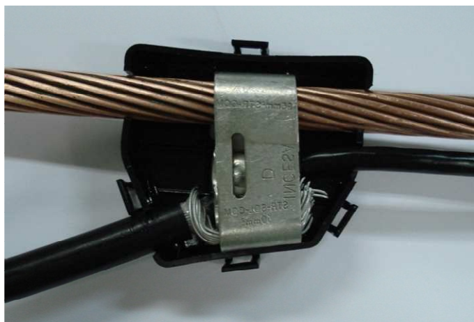
Figura 2 - Instalação do condutor neutro
